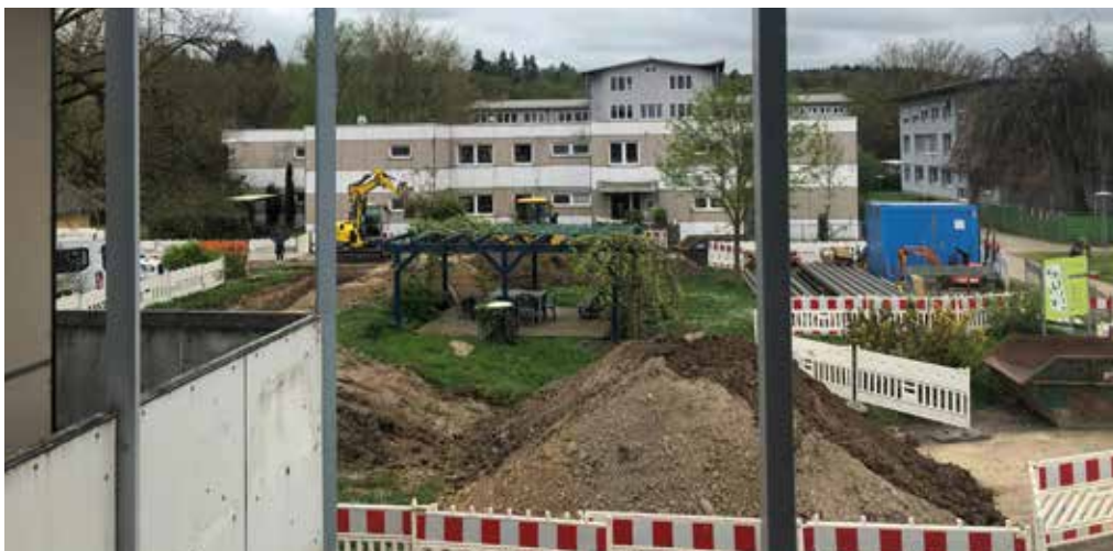
Große Teile des Geländes waren Baustelle
