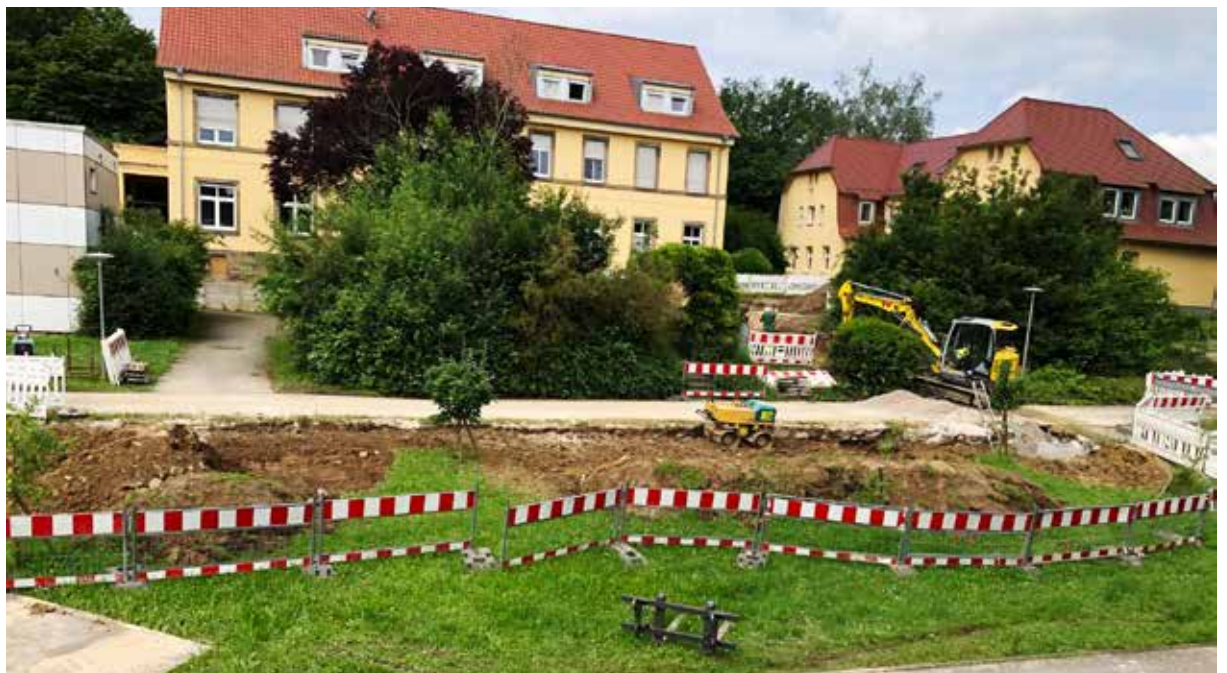
Neue Heizungsrohre und Wasserleitungen wurden verlegt
