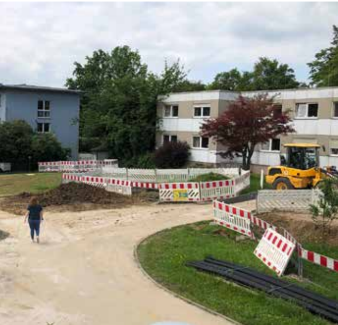
Große Bauarbeiten auf dem Gelände
